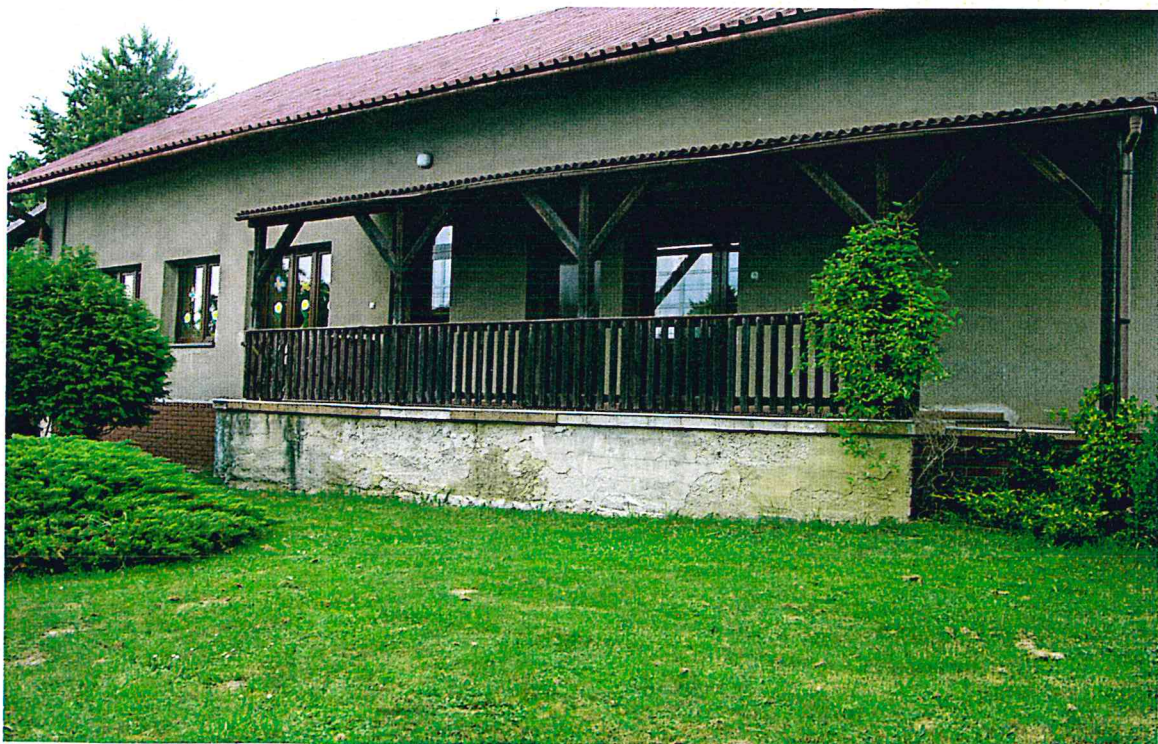
Fotografia nr 3– widok elewacji wschodniej.
