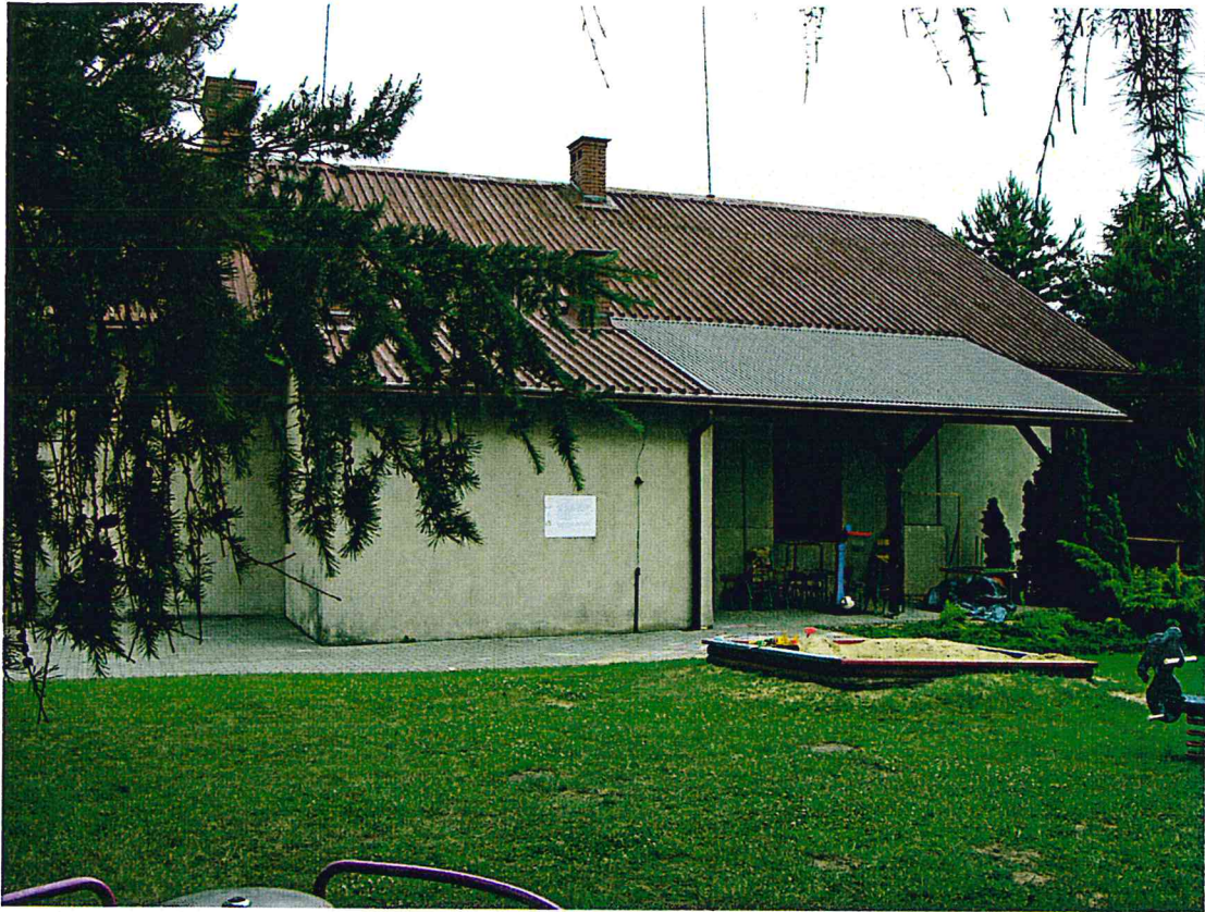
Fotografia nr 2– widok elewacji zachodniej.
