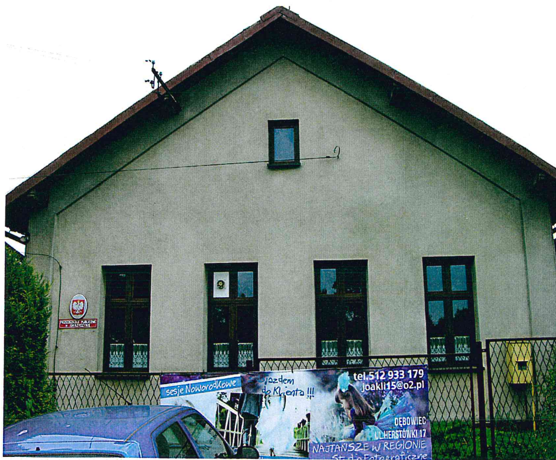
Fotografia nr 1 – widok elewacji północnej.
